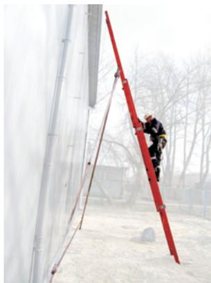
MPS ® est un système d'échelle de plate-forme pour des travaux dans un terrain difficile sans avoir besoin d'appui sur une structure solide, tout en fournissant un travail sur échelle bien stabilisée avec protection contre les chutes de hauteur.
